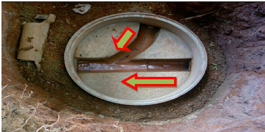
Gambar 7. Contoh Potongan Bak Kontrol (*Precast*)
