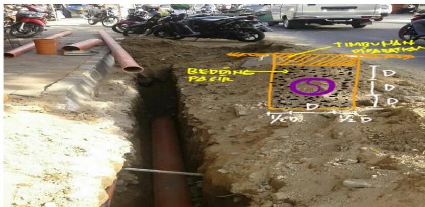
Gambar 11. Contoh Pemasangan Bedding Pasir pada Jaringan
