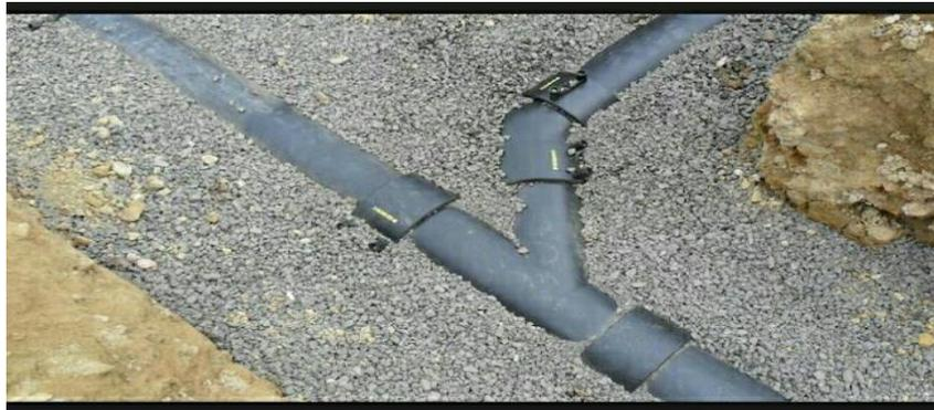
Gambar 10. Contoh Percabangan Pipa (Jika Tidak bisa Pasang Bak Kontrol)
